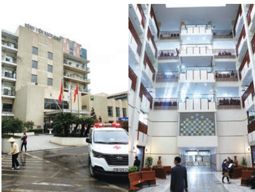
日本のODAによる建設された新病棟
